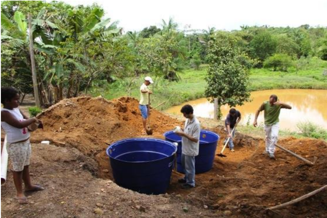
posicionamento e nivelamento das caixas d'água de 1000l.
