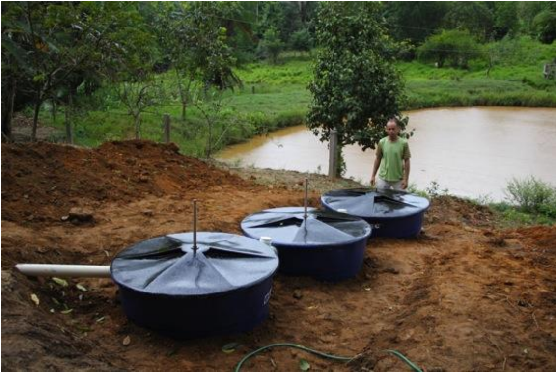
sistema biodigestor concluído
