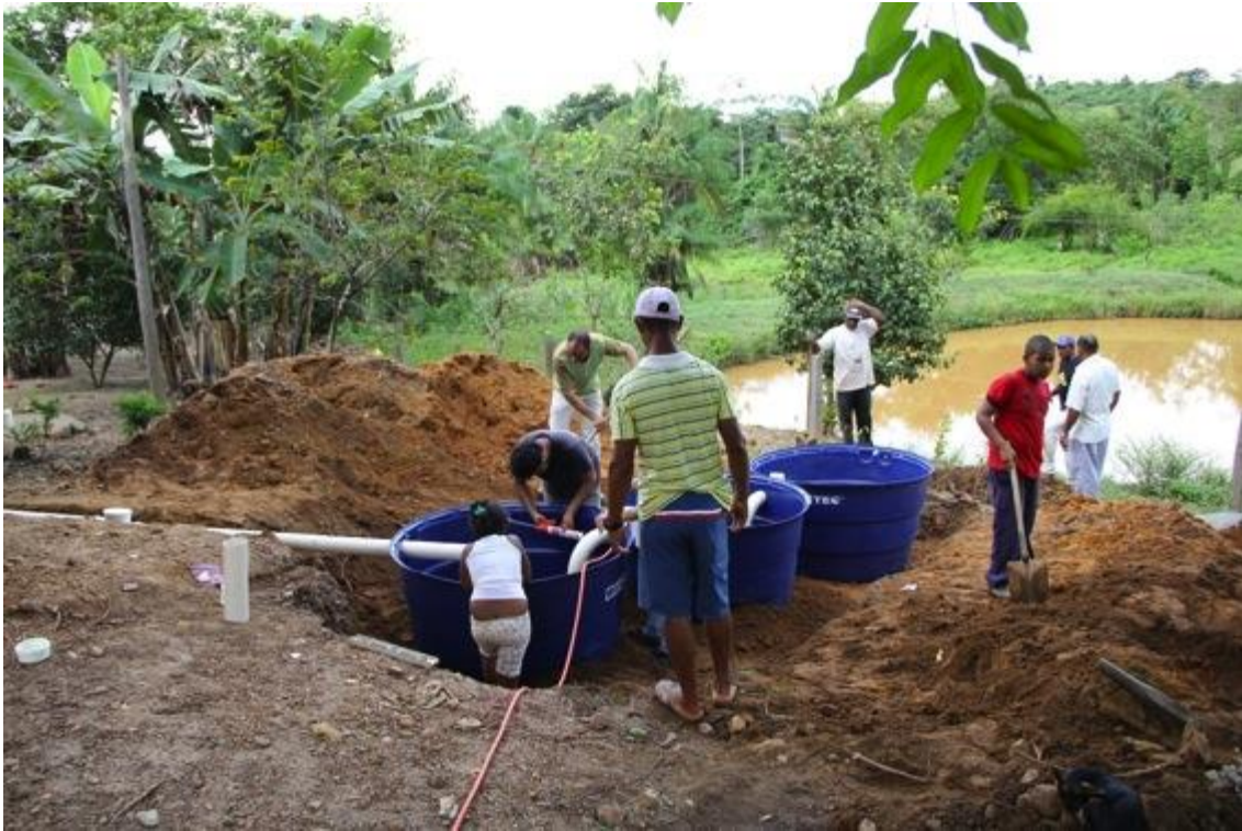
posicionamento e nivelamento finalizado e montagem das conexões
