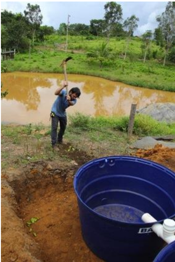
abertura da valeta para inclusão do tubo e registro para retirada de adubo
