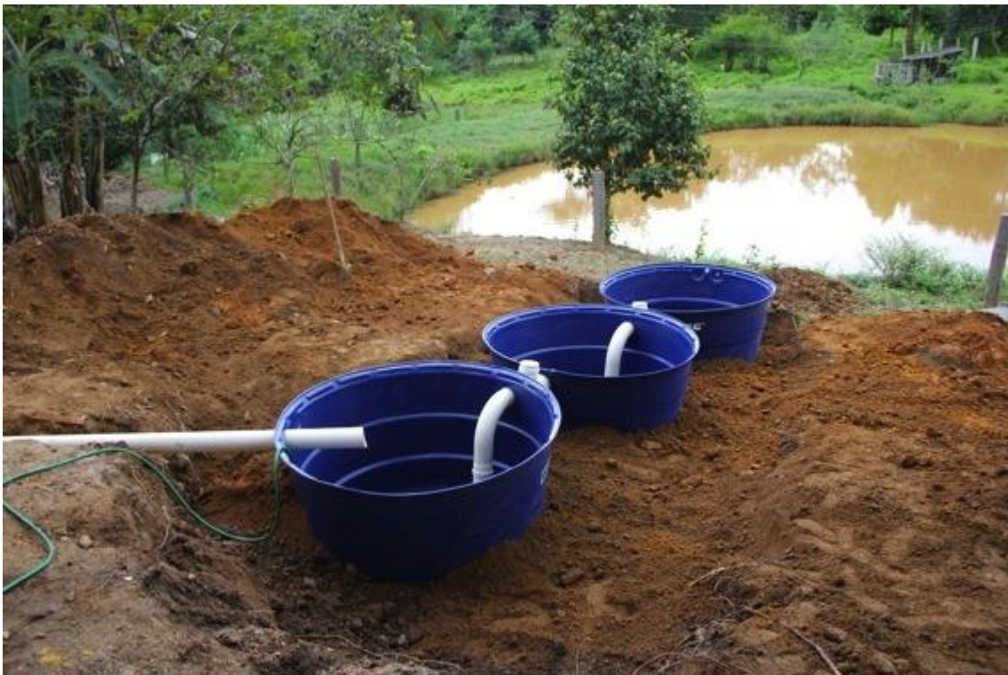
vedação das caixas biodigestoras
