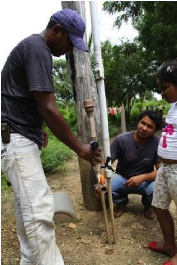
instalação do clorador na rede domiciliar de abastecimento da caixa d'água.
