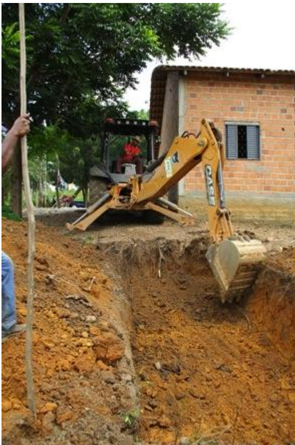
abertura da vala pela retroescavadeira da prefeitura
