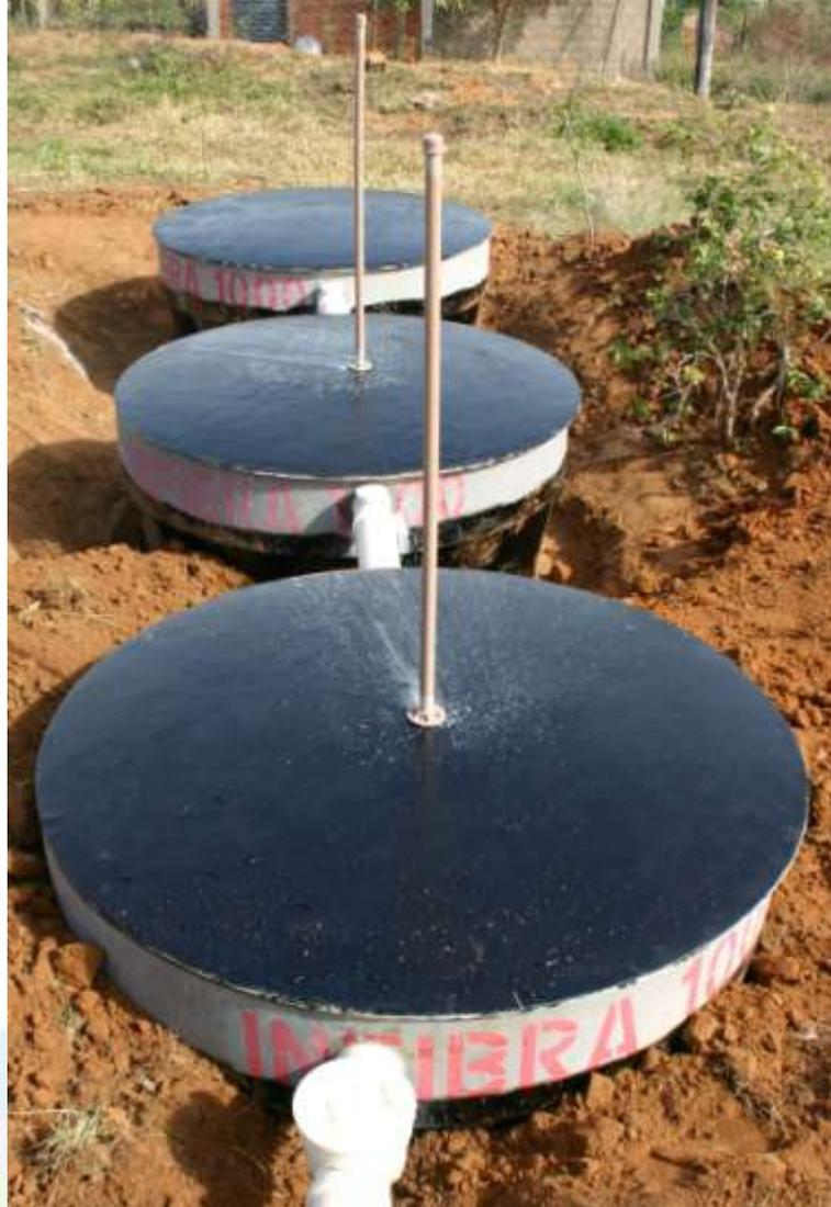
Fossa Séptica Biodigestora com destaque para sistema de alívio de gases. Foto de Valentim Monzane.
