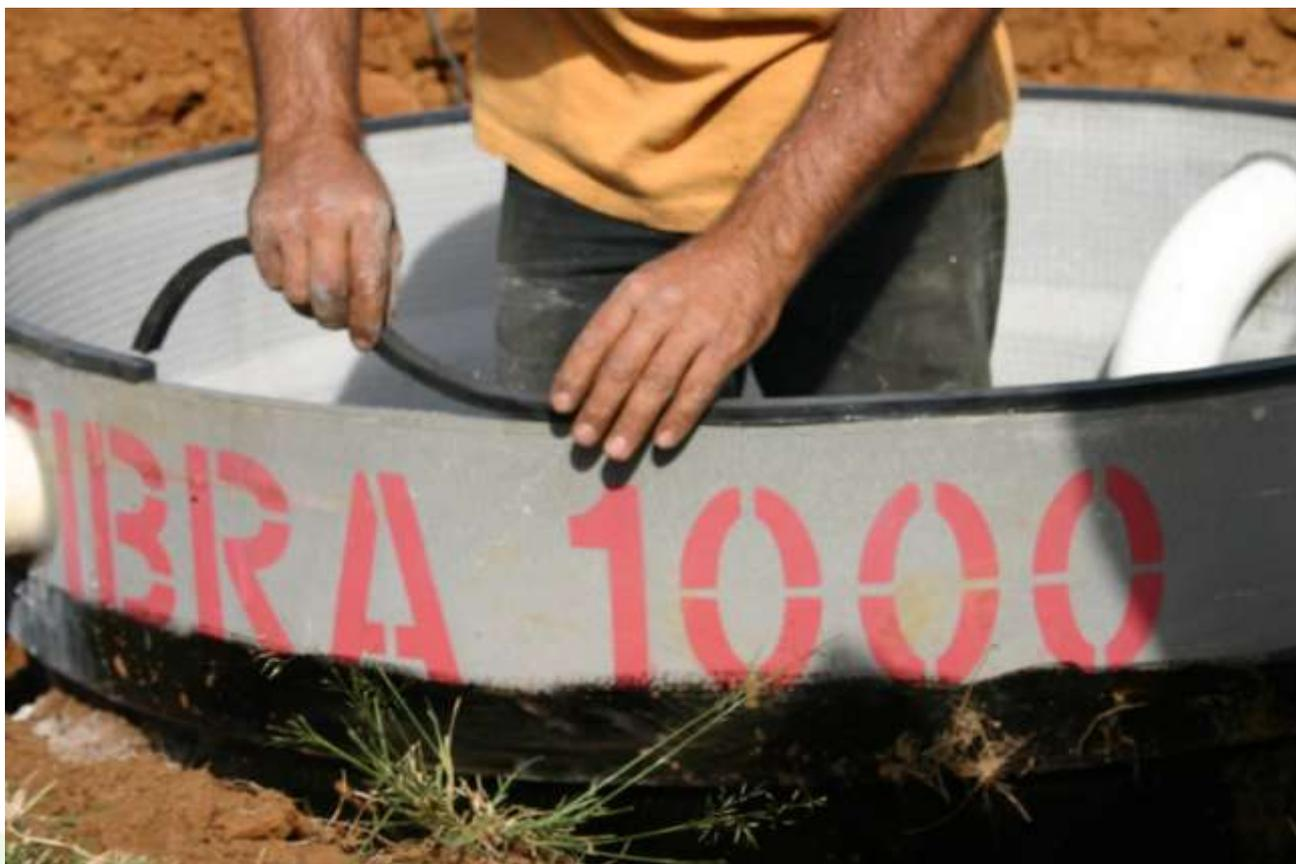
Vedação das caixas da Fossa Séptica Biodigestora com borracha macia.
